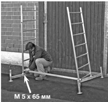
Базовая конструкция с первой надстройкой
