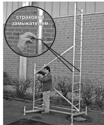
Базовая конструкция с первой надстройкой
