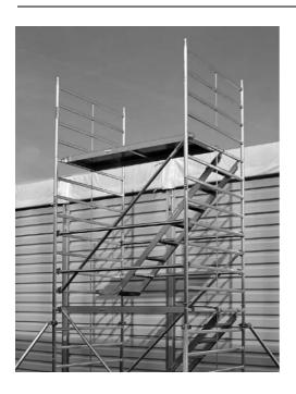
Wenn sie auf die obere Belagbühne gestiegen sind und einen sicheren Stand haben, lassen sie sich die beiden 1 m Vertikalrahmen anreichen. Stecken Sie die beiden Vertikalrahmen auf und sicheren Sie die Verbindung mit Fallsteckern.
