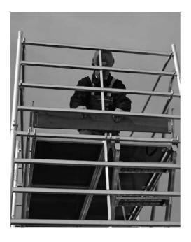
Lassen sie sich die beiden Querbords anreichen. Setzen Sie die Querbords, wie im nebenstehenden Bild gezeigt, mit den Haken auf die erste Sprosse über die beiden dicht aneinanderliegenden Belagbühnen ein.
