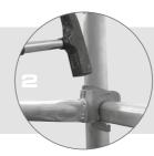
Alle Geländer- und Diagonalstreben müssen unmittelbar nach dem Zusammenstecken verriegelt werden.
