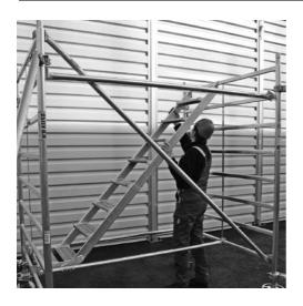
Setzen Sie einen Treppenlauf von der ersten zur achten Sprosse in die Vertikalrahmen ein, verriegeln Sie die Verbindungen und sichern Sie den Lauf oben mit einem Fallstecker.
