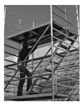
Hängen Sie die Belagbühne mit der großen Luke in die Sprosse über die oberen Haken der Treppe. Die Luke muss nach außen klappen. Schieben Sie die beiden Belagbühnen dicht aneinander.
