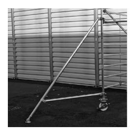
Vor dem weiterem Aufbau montieren Sie zuvor die vier Ausleger an die Vertikalrahmen wie im nebenstehenden Bild zu sehen. Öffnen Sie die Kupplungen und legen Sie diese um das Stielrohr des Vertikalrahmens. Haken Sie dann die Hammerkopfschraube ein und ziehen die Flügelmutter handfest an.
